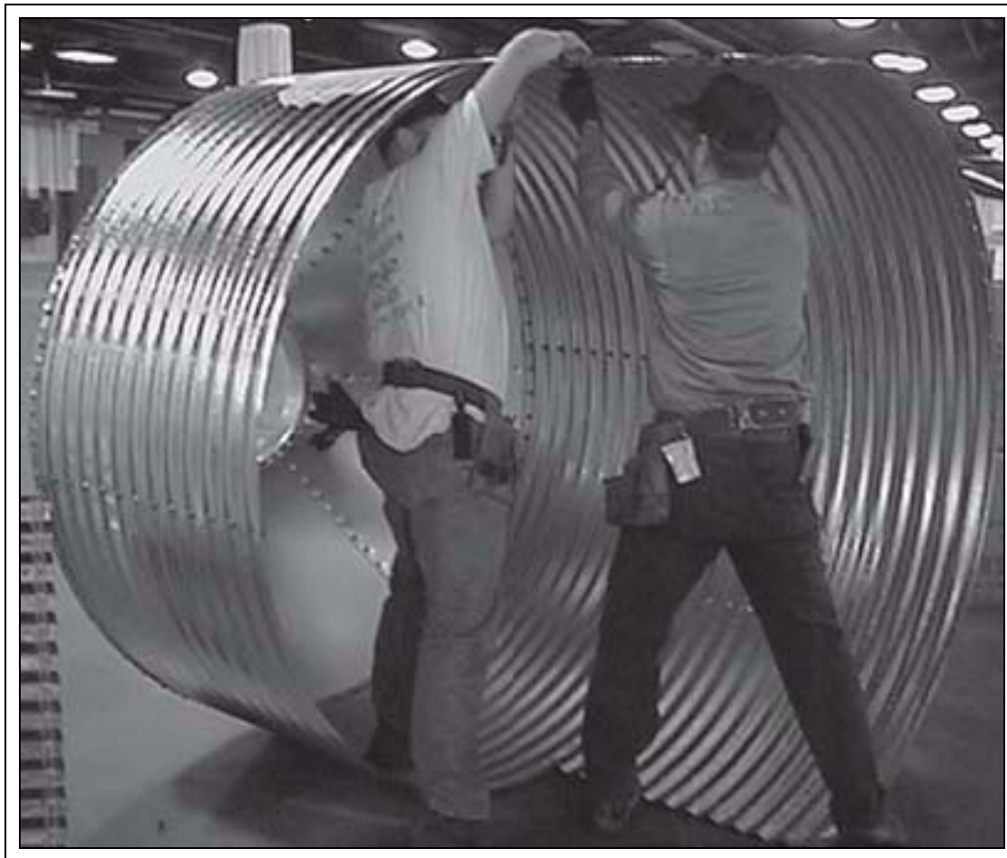
Рисунок 6F Сборка боковых стенок
